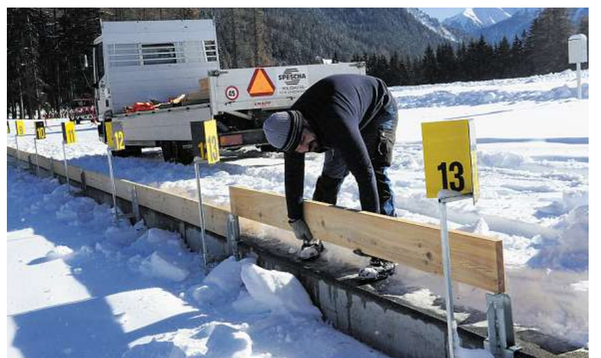
Auf der Zielgeraden: Die letzten Bauarbeiten laufen.
