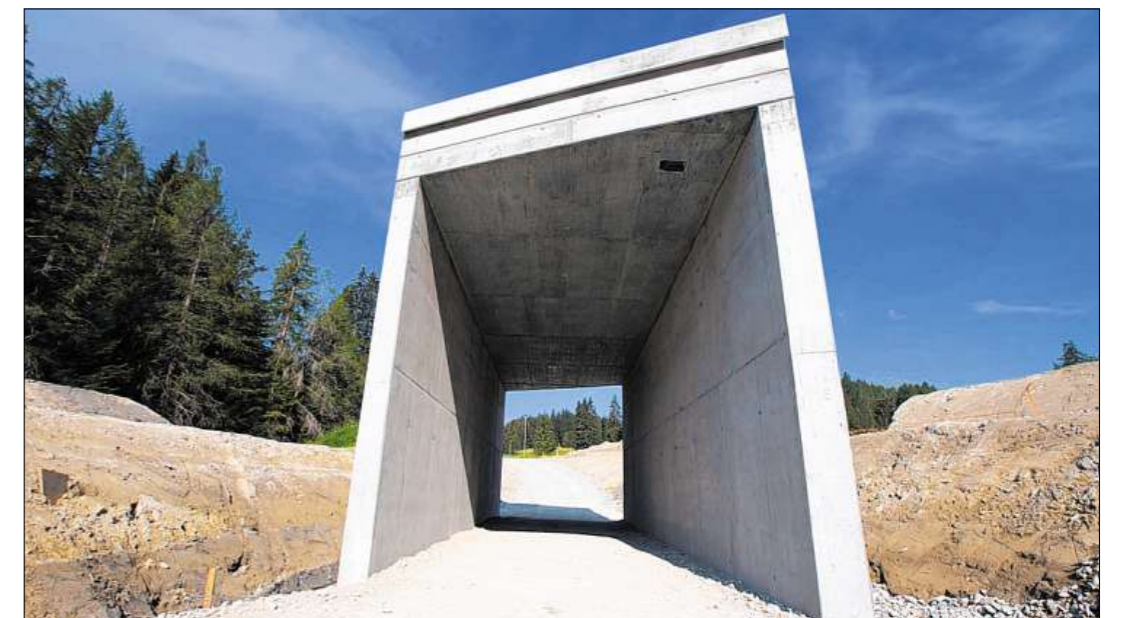
Eine Unterführung steht schon.
